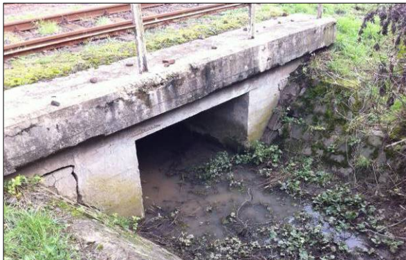
vasútvonal alatti csapadékvíz-elvezető
