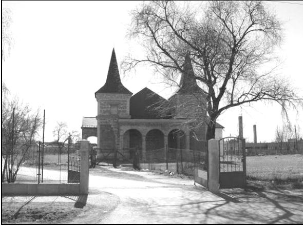
A kastély északi homlokzata
