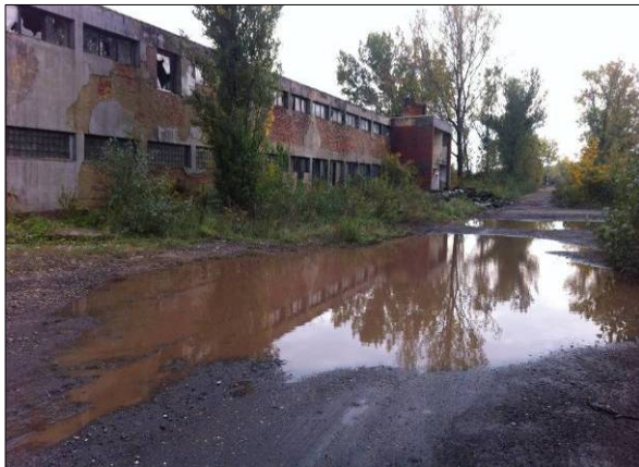
102/5 hrsz.-ú közlekedési terület, egykori állomás
