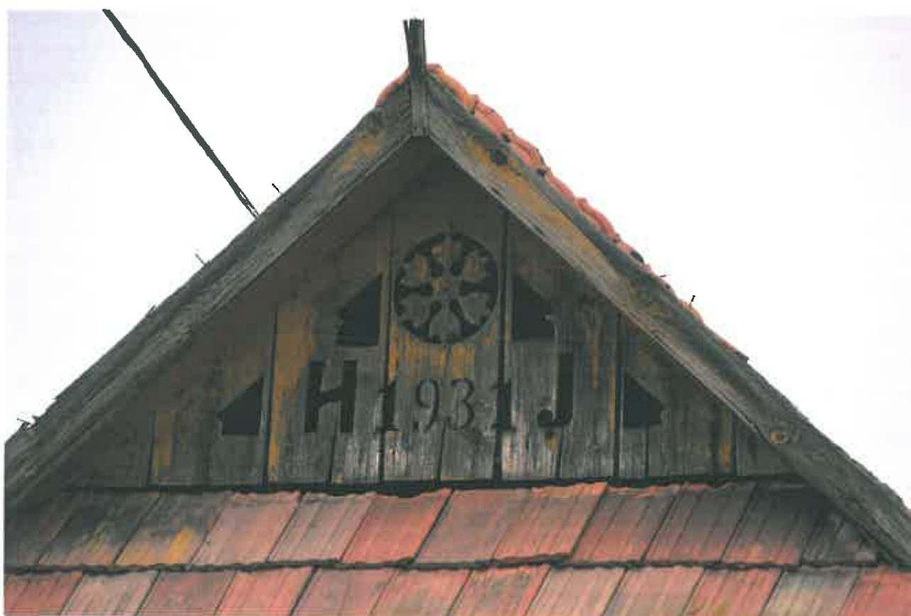
AZ OROMDÍSSZEL RENDELKEZŐ CSONKA KONTYOLT TETŐSZERKEZETEK SZIRMABESENYŐ KIEMELKEDŐ ÉPÍTÉSZETI ÉRTÉKEI ▲ ▼
