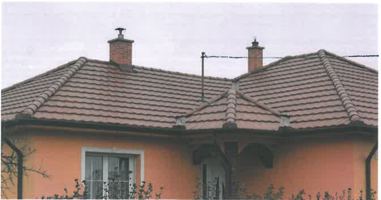
MEGFELELŐ ELHELYEZÉSŰ, TETŐSZERKZETHEZ ILLESZKEDŐ KÉMÉNYEK ▲ ▼
