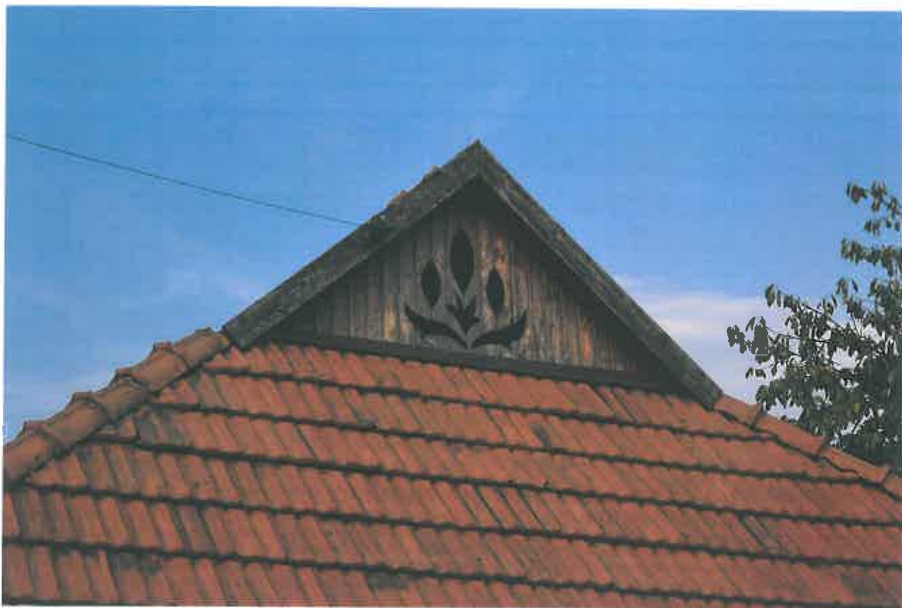
AZ OROMDÍSSZEL RENDELKEZŐ CSONKA KONTYOLT TETŐSZERKEZETEK SZIRMABESENYŐ KIEMELKEDŐ ÉPÍTÉSZETI ÉRTÉKEI ▲ ▼
